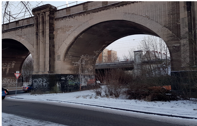
Bogen als Durchfahrt (links) und untergenutzter Bogen (rechts) - 02/2018
